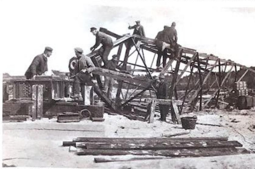
Einer der im Bau befindlichen, bereits 30 Meter hohen Unterzonenmasten des verhüllten Deutschlandbundes, der auf dem Gelände in Zehlendorf bei Königswusterhausen errichtet wird, ist infolge eines Sturmes zusammengebrochen.
